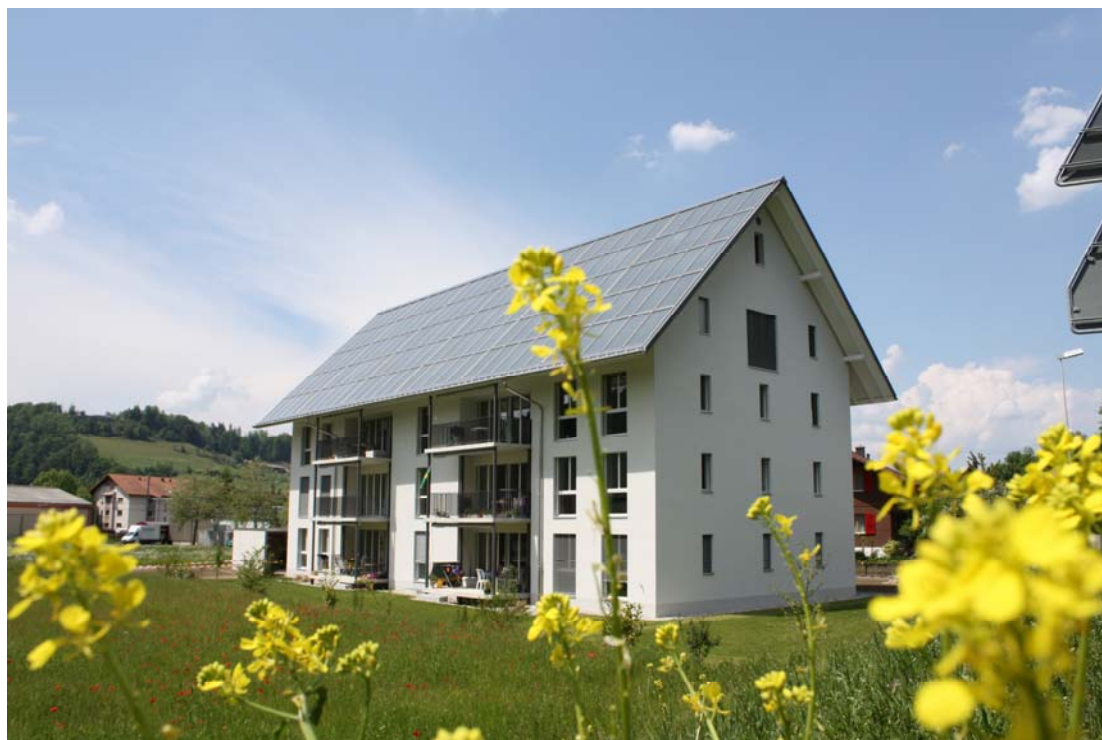
Bild: Jenni Energietechnik AG, Oberburg
