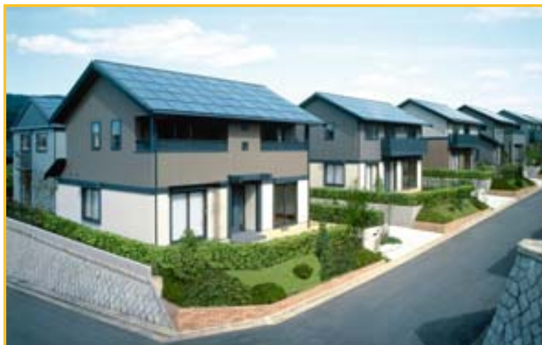
Un nouveau quartier de Misawahome à Aichi. Toutes les maisons disposent d'une installation photovoltaïque. Le coût d'une maison – avec le terrain – s'élève à environ 550 000 CHF
