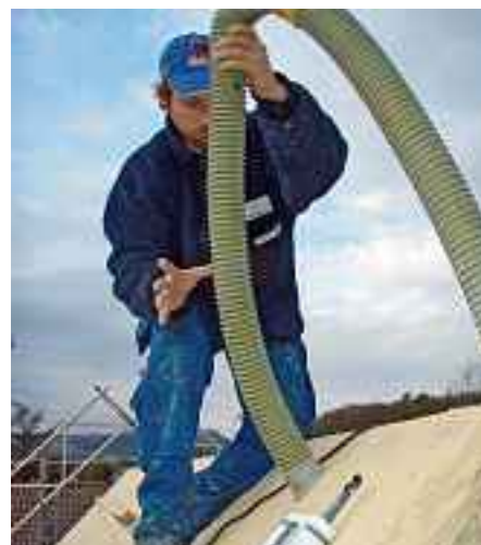
Die Dachkonstruktion wird mit Zellulose gefüllt
