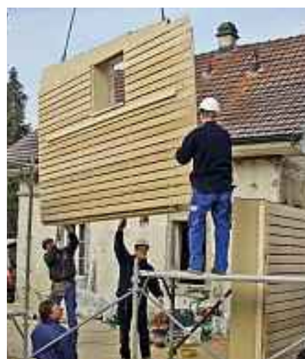
Der Anbau wird aufgestellt
