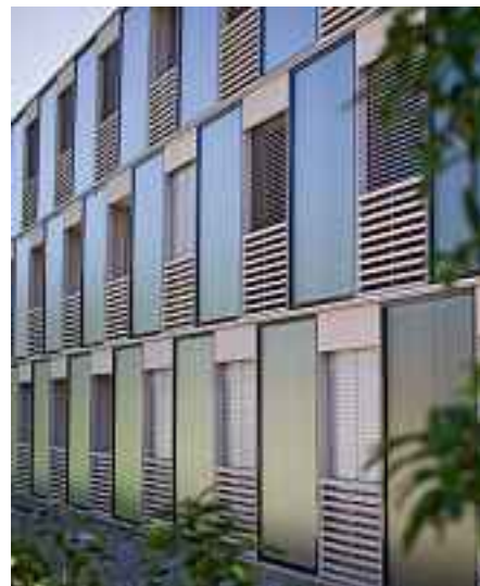
Die Kollektorelemente bilden gleichzeitig die Fassade
