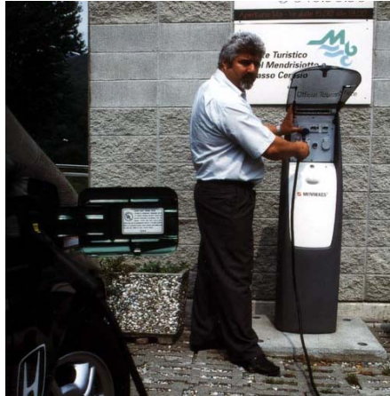
Öffentliche Ladestation: Park & Charge
