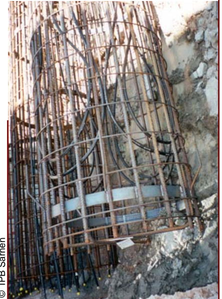
Energiepfahl vor Einbringung
