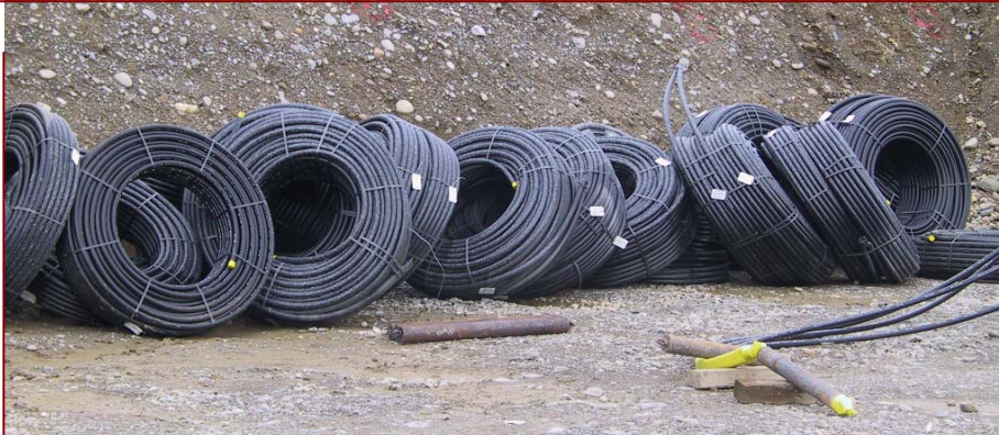
Kunststoffröhren für einen Geothermiespeicher
