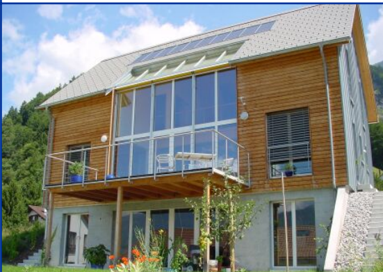
Das Minergiehaus Jenins hat dank erneuerbaren Energieträgern geringere Betriebskosten als ein konventionelles Haus.
