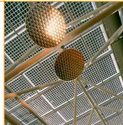
Photovoltaikanlage auf dem Migros Center Limmatplatz, Zürich, Maximalleistung 31 kW (119 Module)
