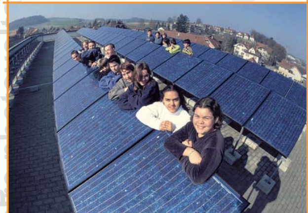
Installation photovoltaïque sur l'école Steighof, à Burgdorf © SSES
