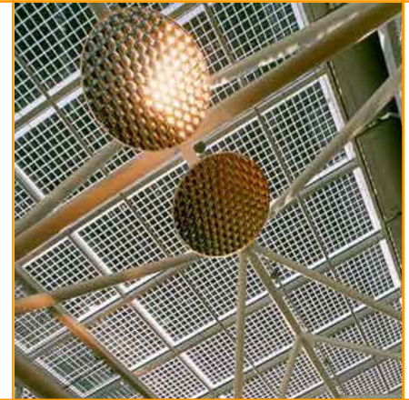
Installation photovoltaïque d'une puissance crête de 31 kWp (119 modules) sur le centre Migros de la Limmatplatz, à Zurich
