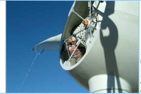
Windenergieanlage Gütsch: Montage der Nabe
