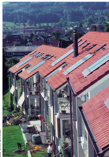
Fünf von sechs Wohngebäuden weisen ein nutzbares solarthermisches Potenzial auf.
