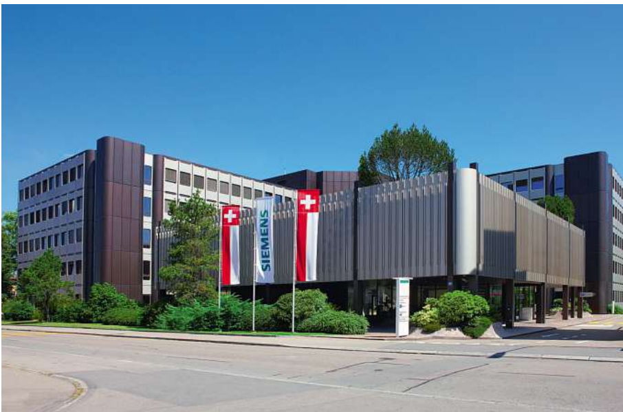
Foto: Siemens Schweiz AG
