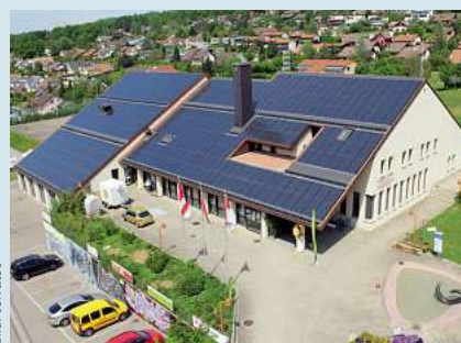
Vorbildlich integrierte PV-Anlage auf dem Dach der Mehrzweckhalle.
