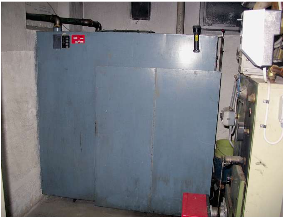
Der alte Öltank als neuer Wassertank für die solare Heizungsunterstützung?
