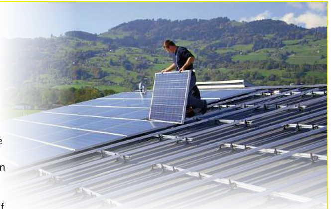
Rationelle Montage von Solarpanels auf dem Dach der Landi in Altstätten.
