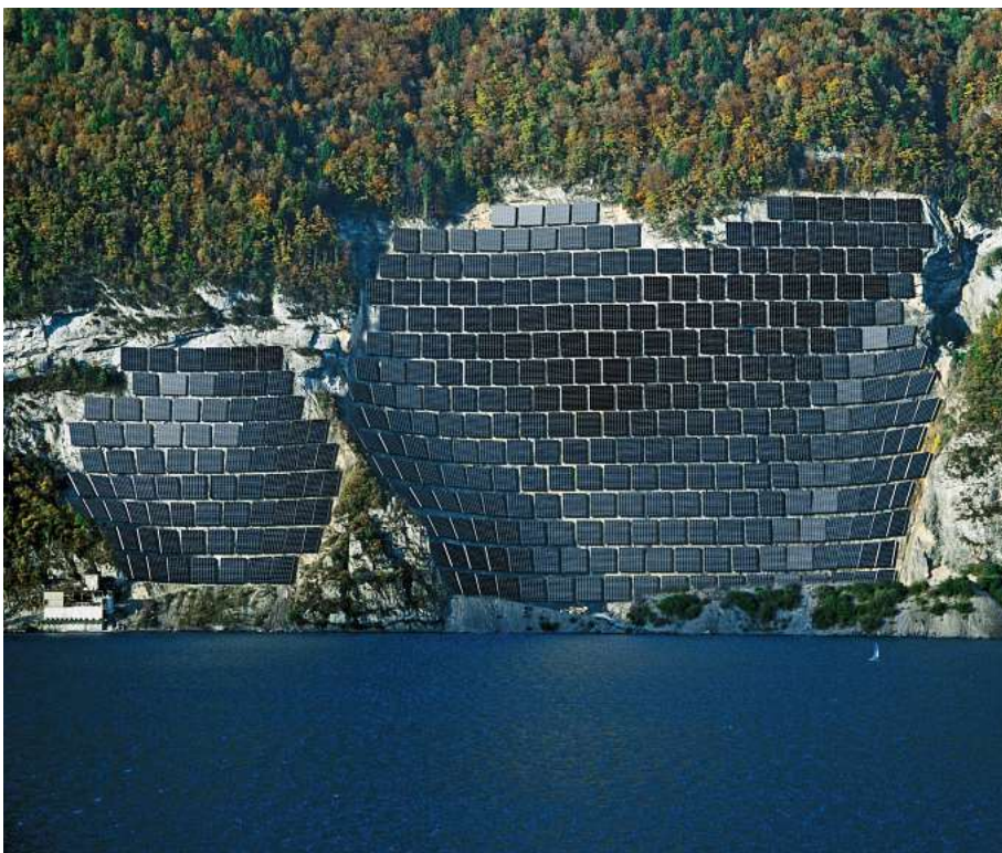
EKZ-Projekt am Walensee: Solarer Strom für 1400 Haushalte.
