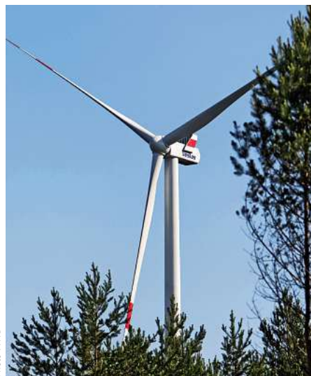
Photo : IWB Installation des IWB du parc éolien Calau.
