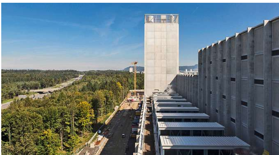
Centrale énergétique Forsthaus : électricité, vapeur et chauffage à distance produits à partir de déchets, de bois et de gaz naturel.
