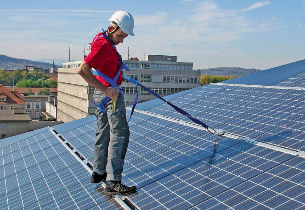
Moderne Photovoltaikanlage mit integrierter Absturzsicherung für Reinigung und Instandhaltung.
