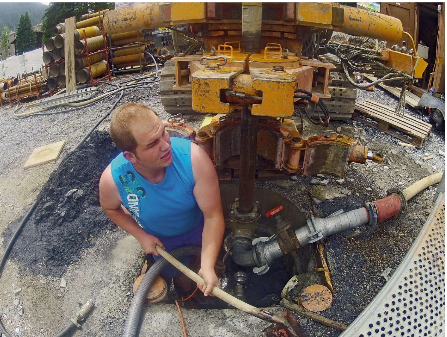
Schweres Gerät: Ein Arbeiter im Bohrloch im Davoser Kurpark.
