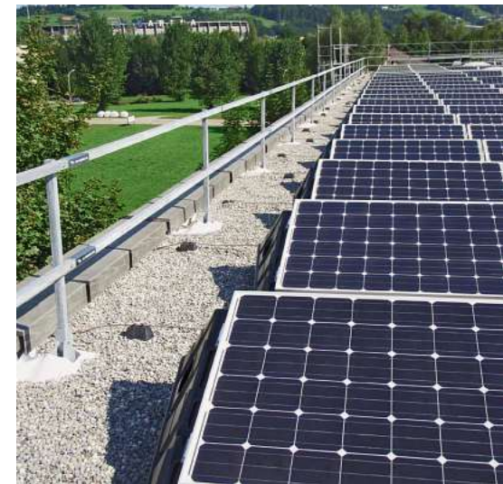
Kollektivschutz für den Unterhalt: herunterklappbares Geländer.
