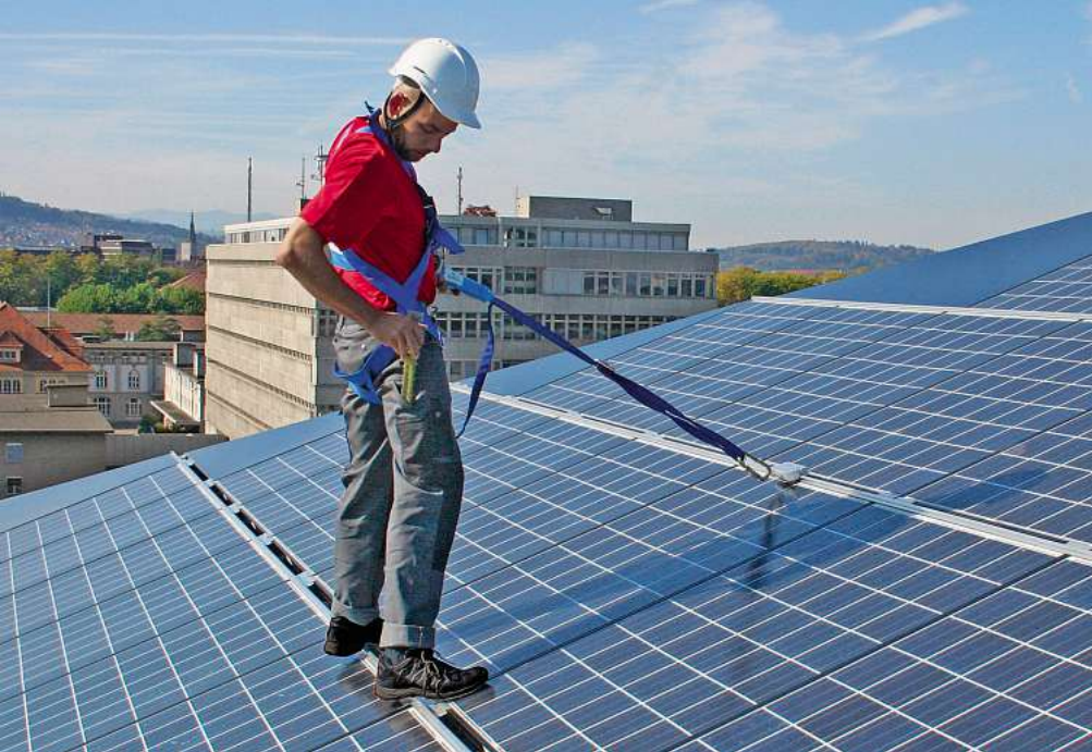
Installations photovoltaïques modernes avec un système permanent de protection contre les chutes pour le nettoyage et l'entretien.
