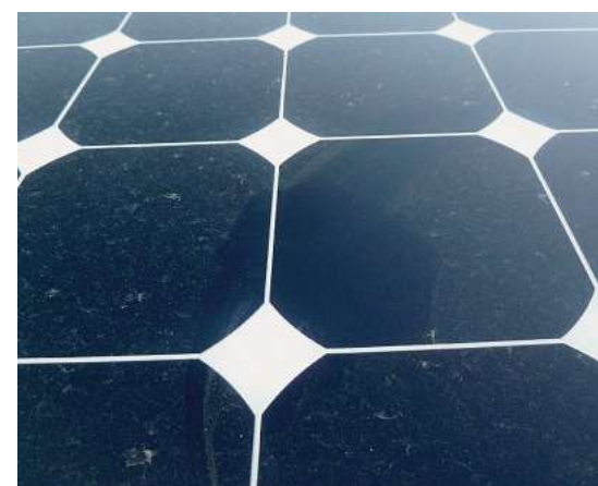
Cellules solaires salies par des dépôts de poussières.
