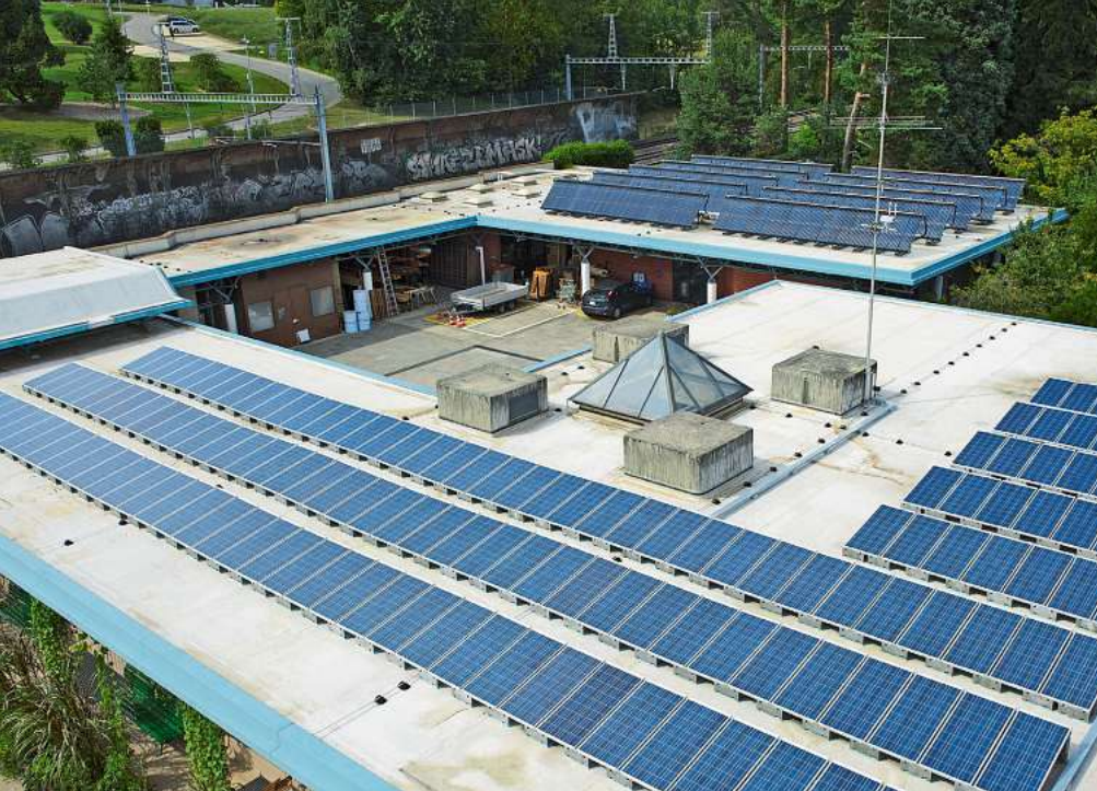
Panneaux thermiques et centrale solaire photovoltaïque.
