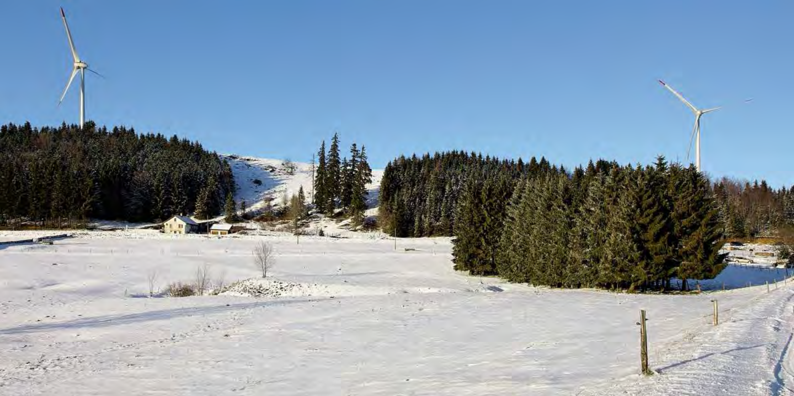
Der erste Schweizer Bürgerwindpark wurde 2009 im jurassischen St. Brais errichtet.
