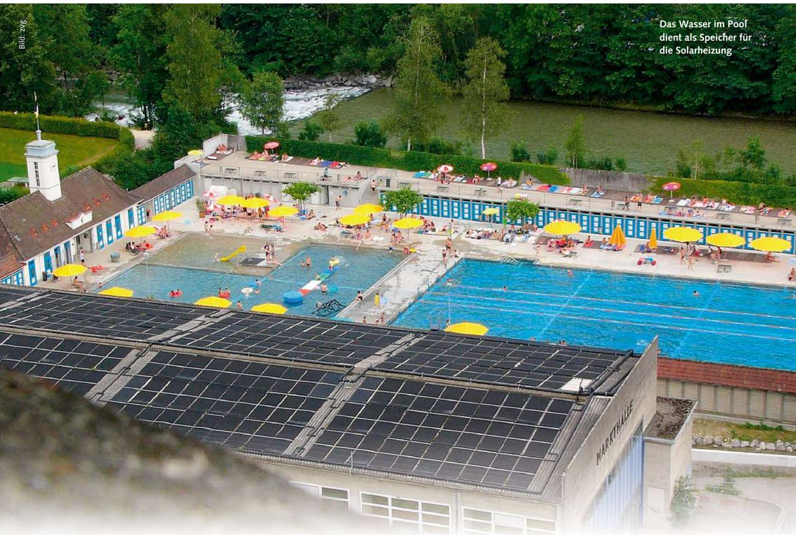
Das Wasser im Pool dient als Speicher für die Solarheizung
