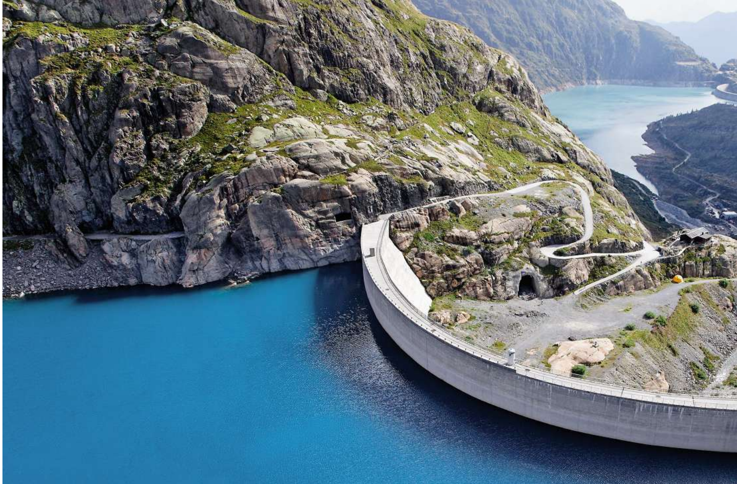
Les lacs de barrage comme le Nant de Drance (VS) permettraient un approvisionnement en électricité à 100% renouvelable – même durant des années mauvaises pour le solaire ou l'éolien.
