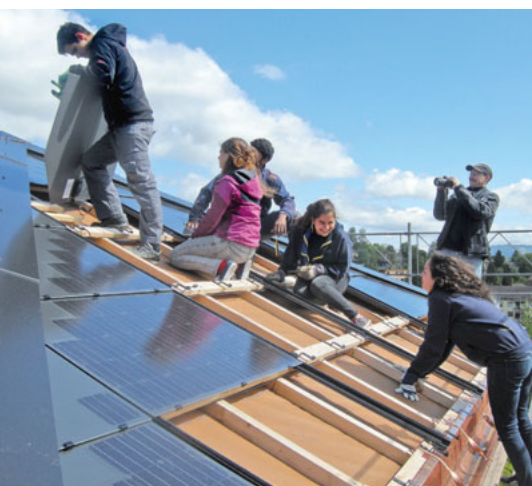
Die Pfadi installiert die 4. Solaranlage.
