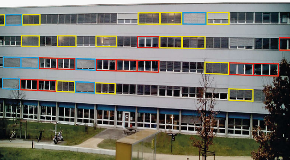
Westfassade eines Bürogebäudes, dessen Fenster mit manuell bedienten Storen ausgerüstet sind. Dieses Foto – aufgenommen an einem bedeckten Nachmittag im Jahr 2013 – zeigt, dass die Nutzung der Storen sehr zufällig ist. Nur ein geringer Teil von ihnen befindet sich in einer zweckmässigen Position, also vollständig hochgezogen (rot). Andere sind in der ungünstigsten Position, nämlich vollständig heruntergelassen (blau). In etlichen Büros sind die Lampen eingeschaltet, während die Storen teilweise heruntergelassen sind (gelb).
