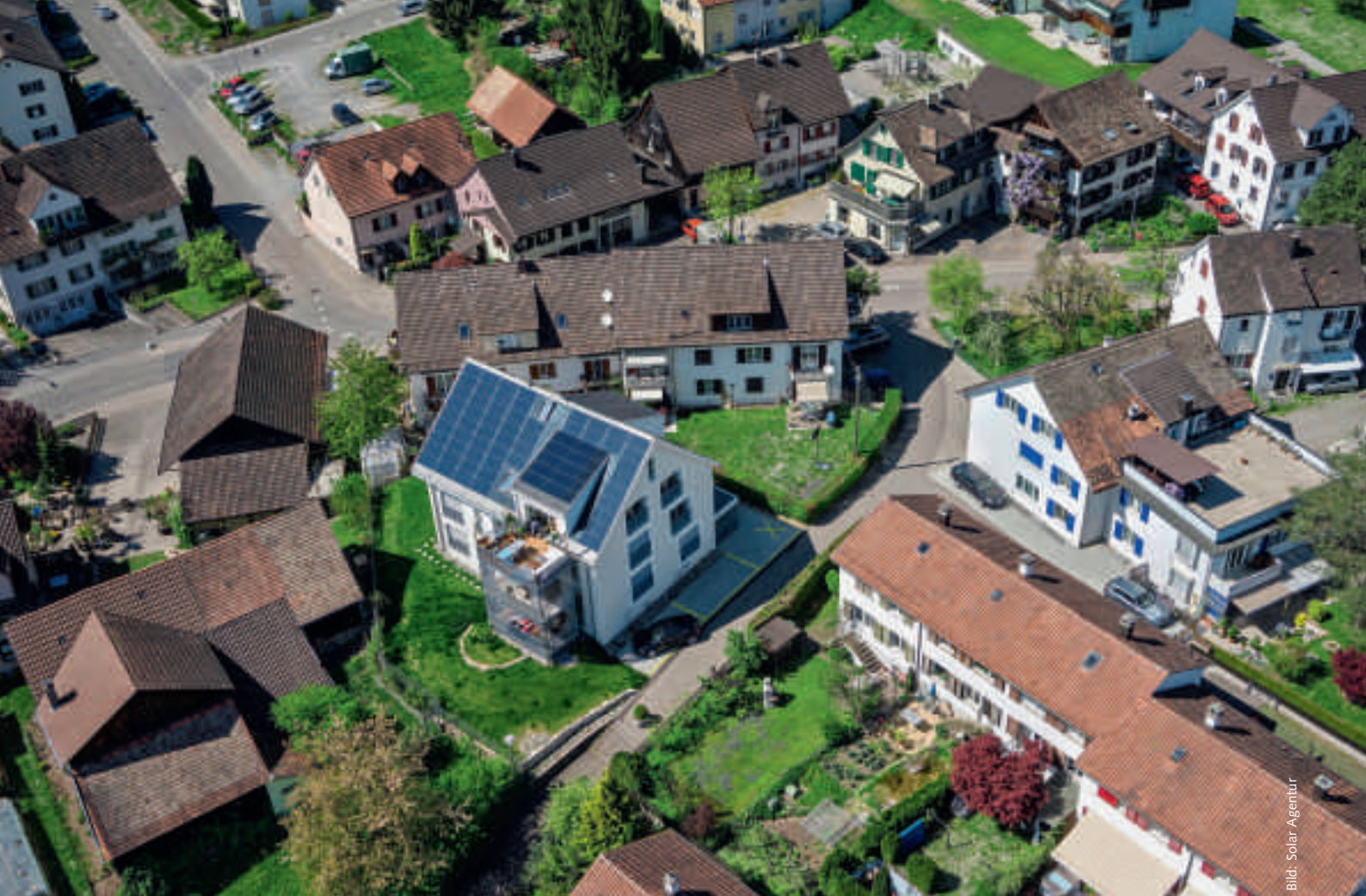
Das 131%-PlusEnergie-Mehrfamilienhaus in Oberengstringens (ZH) Kernzone konsumierte vor der Sanierung 66750 kWh/a, heute benötigt es noch 18755 kWh/a und erzeugt 24500 kWh/a.
