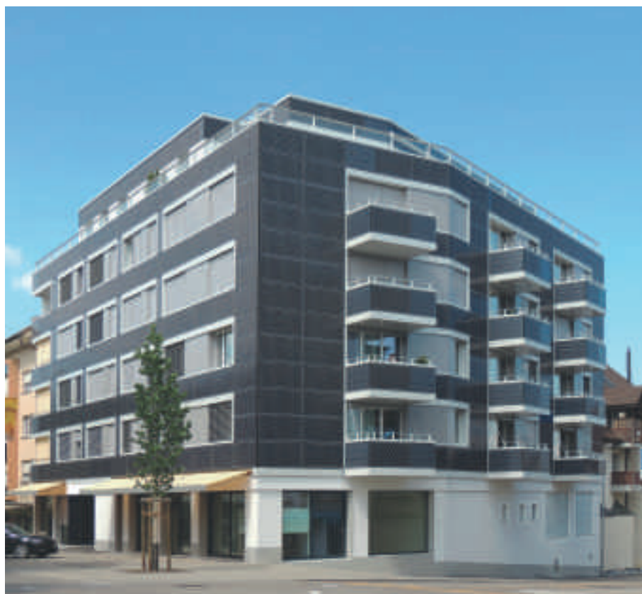
Der 131%-PlusEnergiebau in Romanshorn (SG) benötigte vor der Sanierung 300 000 kWh/a, nachher nur noch 84 000 kWh/a, obwohl aus 6 neu 22 Wohnungen realisiert wurden. Die Solaranlagen erzeugen rund 90 000 kWh/a. Mit dem Solarstromüberschuss kann ein Elektroauto fast einmal die Welt umrunden.
