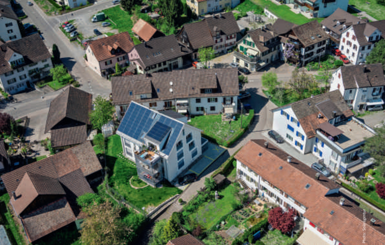
L'immeuble à énergie positive de 131 % d'Oberengstringen/ZH consommait avant l'assainissement 66750 kWh/a. Depuis son assainissement, il consomme 18755 kWh/a et produit 24500 kWh/a. Le courant en excès permet de faire environ une fois le tour du monde en voiture électrique.
