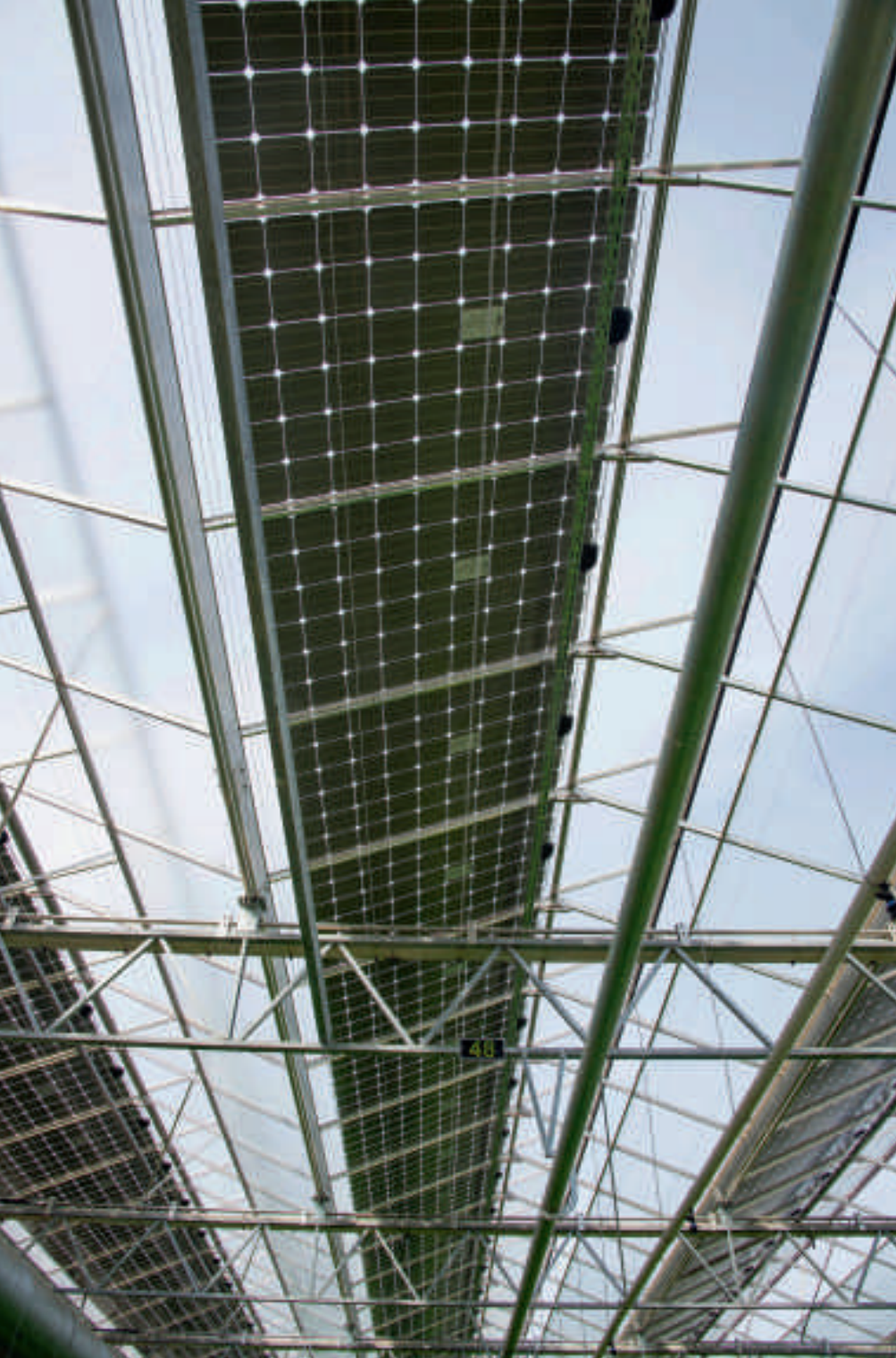
Les modules de l'entreprise autrichienne PVP sont placés entre deux verres diffus.
