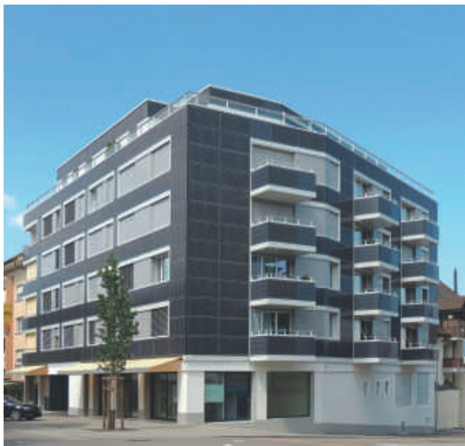
Le BEP de 131 % à Romanshorn/SG consommait avant l'assainissement 300 000 kWh/a. Depuis son assainissement, il consomme 84 000 kWh/a et produit 90 000 kWh/a. Le courant en excès permet de faire environ une fois le tour du monde en voiture électrique.
