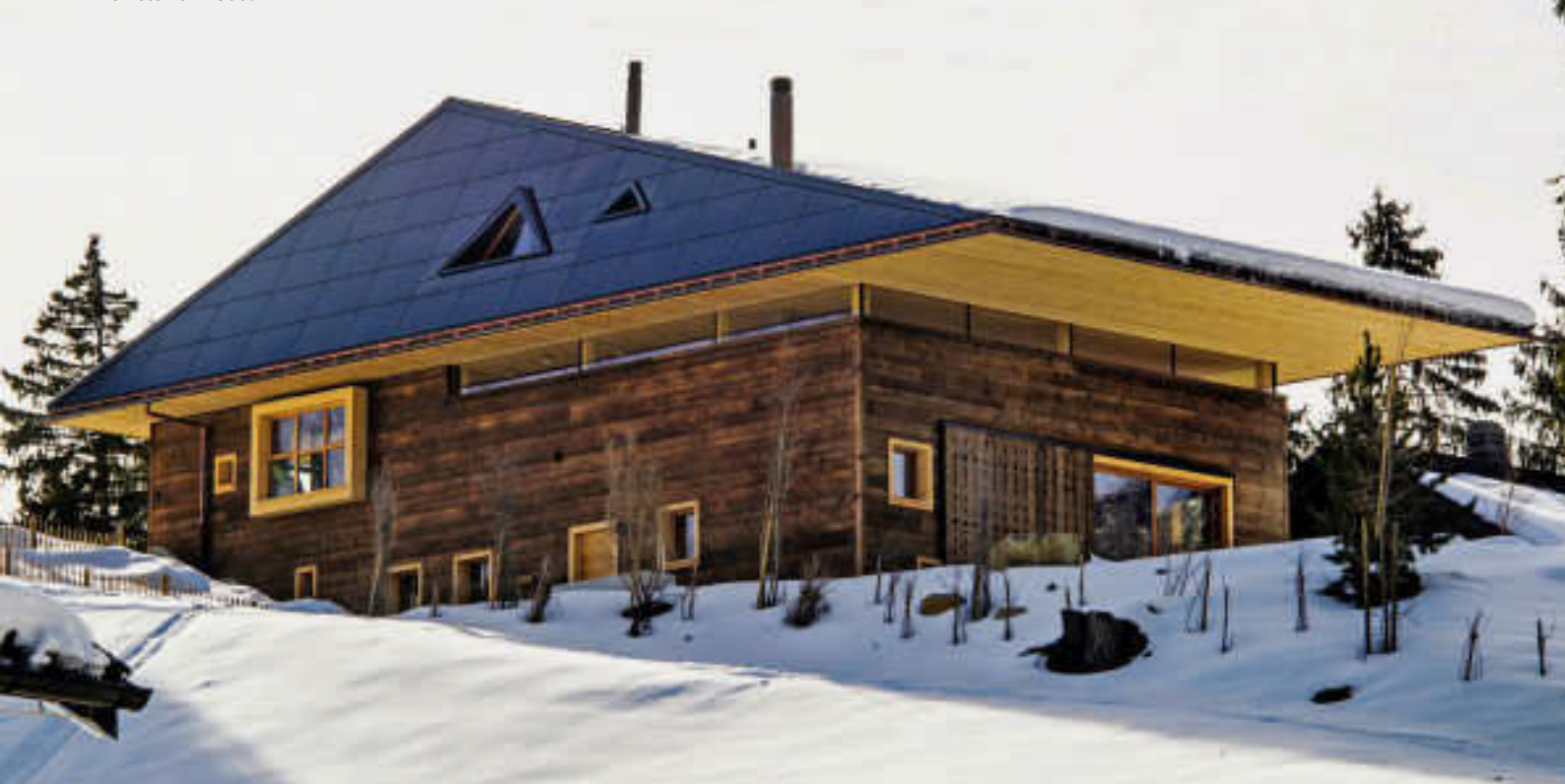
Das Wohn- und Geschäftshaus von Reto und Birgit Sieber in Sörenberg (LU) auf 1100 m ü. M. hat eine Eigenenergieversorgung von stolzen 486%.
