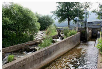
Bereits genutzte Gewässer könnten durch den Einbau von Fischtreppe wie hier in Süddeutschland ökologisch aufgewertet werden.
