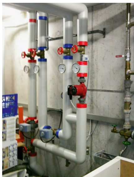
Der EcoGateway wird im Heizungsraum installiert und zwischen den bestehenden Vorlauftemperaturfühler (graues Kästchen über dem Thermometer des Heizungsvorlaufs) und die bestehende Regulierung geschaltet.
