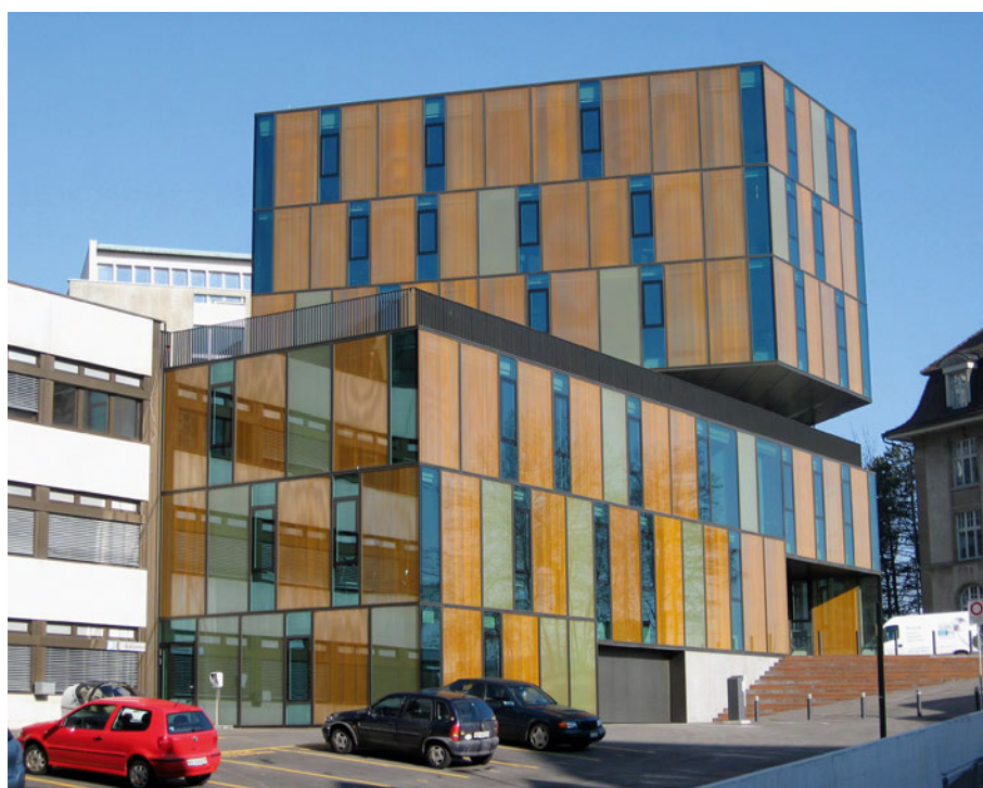
La régulation du chauffage basée sur les pronostics météorologiques a été installée pour la première fois dans ce bâtiment scolaire MINERGIE à la façade entièrement vitrée mis en service en 2008 dans la ville de Fribourg.
