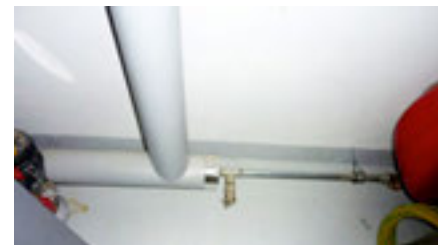
Die Stichleitung zum Expansionsgefäß darf nicht gedämmt werden, alles andere muss gedämmt werden
