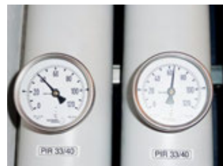
Anlegethermometer mit Sockel ermöglichen die durchgehende Dämmung. Die Mehrkosten sind marginal.
