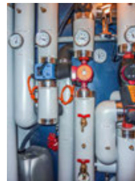
Die Stichleitung zum Expansionsgefäß darf nicht gedämmt werden, alles andere muss gedämmt werden
