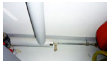
Les conduites de dérivation du vase d'expansion ne doivent pas être isolées, mais le reste oui.
