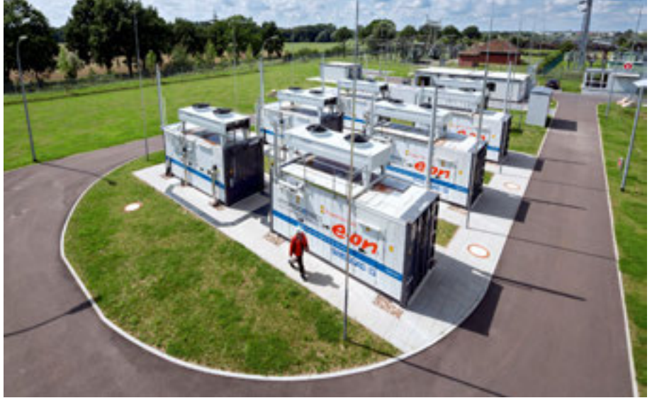
Les distributeurs d'énergie Eon et Swissgas testent, dans le cadre d'un projet pilote de Power to Gas dans l'est de l'Allemagne, comment l'hydrogène peut être stocké dans le réseau de gaz naturel.
