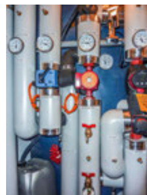
Les conduites de dérivation du vase d'expansion ne doivent pas être isolées, mais le reste oui.
