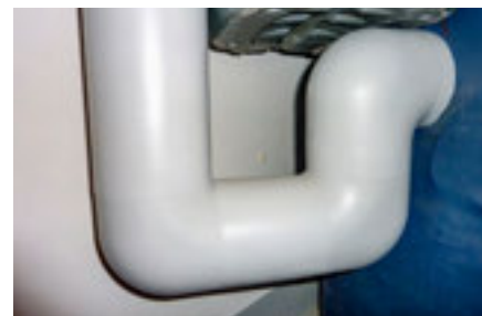
Un siphon parfaitement isolé.
