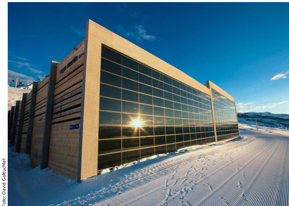
Die Weisses Arena Laax: Die 240 CIS-Module von Manz (75 W) wurden in Einlegeschielen an der Fassade befestigt.
