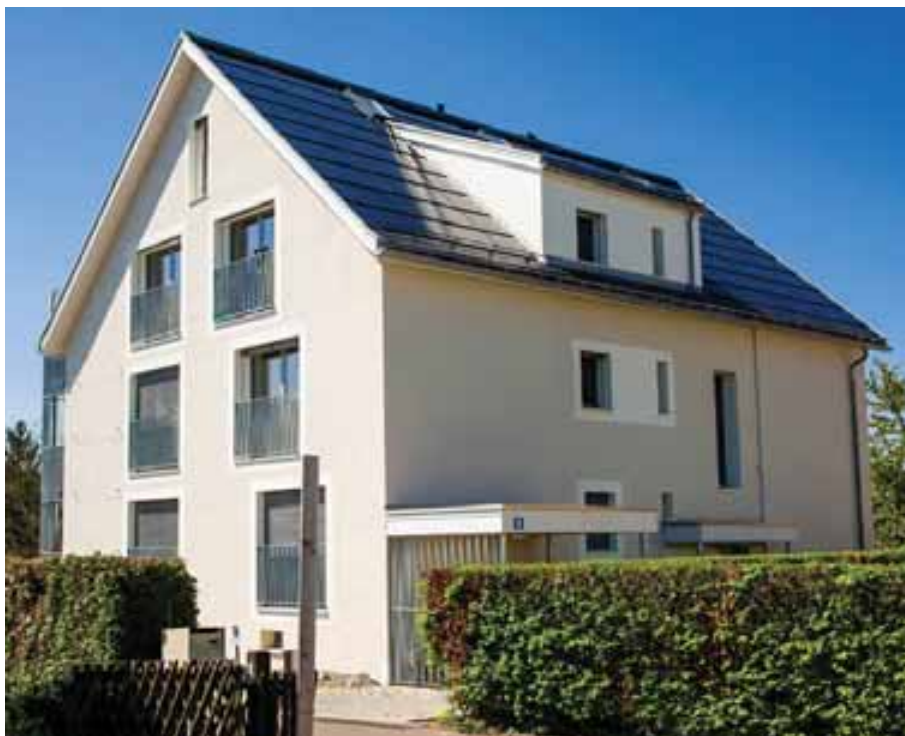
L'année dernière, la maison de quatre familles Hardegger à Oberengstringen a montré ce qui est possible de réaliser avec des rénovations de PEB.
