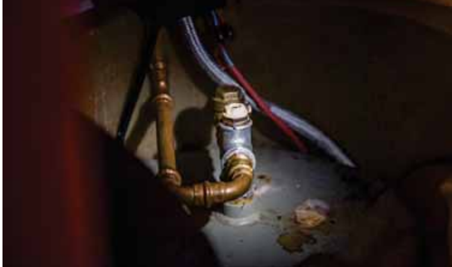
Si des erreurs sont détectées, comme ici, les composants galvanisés à cycle solaire, elles seront listées dans le rapport final.
