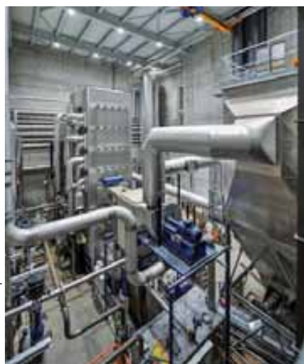
Centrale de chauffage du centre logistique Coop de Schafisheim: au fond sur l'image, la construction en tour de l'échangeur thermique dans laquelle l'huile thermique pour les lignes de cuisson est chauffée avec le gaz de combustion de la chaudière à biomasse. Devant à droite: le séparateur électrique qui retire la poussière fine de l'air extrait.
