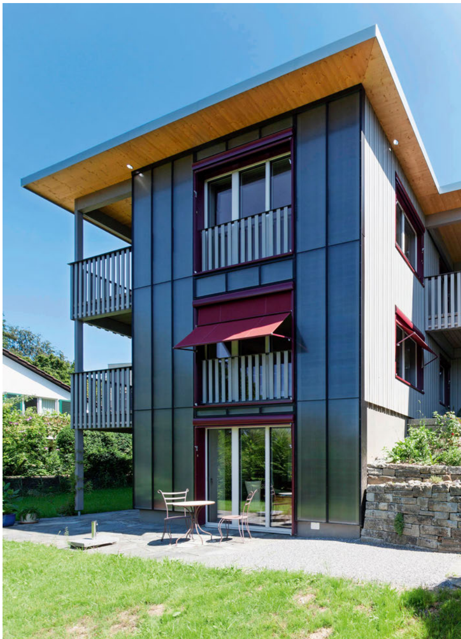
Die Anlage an der Eichhalde fügt sich dank farblich passenden, grauen Solargläsern optimal ins Erscheinungsbild des Gebäudes ein.
