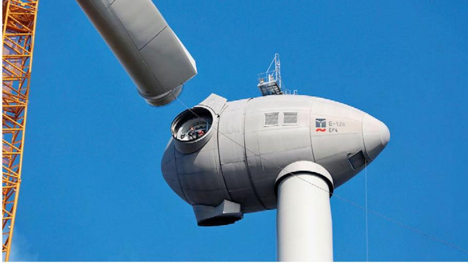
**Neue Landmaschine: Enercon schreitet mit der Serieneinführung der neuen E-126 EP4 voran. Der Prototyp für mittlere Windgeschwindigkeiten mit 4,2 Megawatt Leistung ist in Lelystad in den Niederlanden installiert.**
