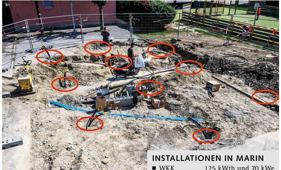
Der saisonale Wärmespeicher, der hier gebaut wird, verfügt über ein Volumen von ungefähr 15000 m<sup>3</sup> und ist mit zehn Sonden ausgerüstet, die bis in eine Tiefe von 100 Metern reichen.
