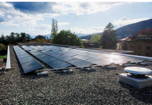
Les absorbeurs solaires en toiture utilisés exclusivement pour la recharge du stock souterrain saisonnier ou directement par l'évaporateur de la PAC.
