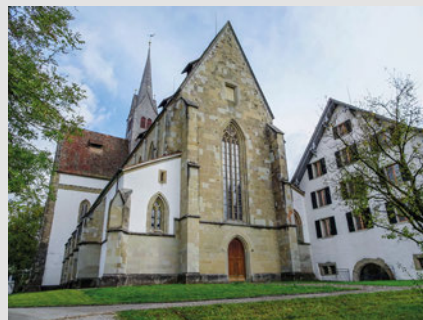
Profitiert ebenfalls vom Holzwärmeverbund: die Kirche des ehemaligen Zisterzienserklosters aus dem 12./13. Jh. Bild: Holzenergie Schweiz
