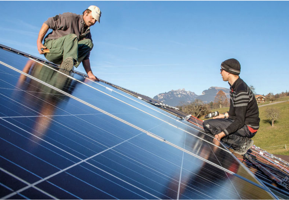
Planer Syril Eberhart ist bei der Ausführung der Arbeiten selber mit auf dem Dach und steht den Selbstbauern mit Rat und Tat zur Seite.
