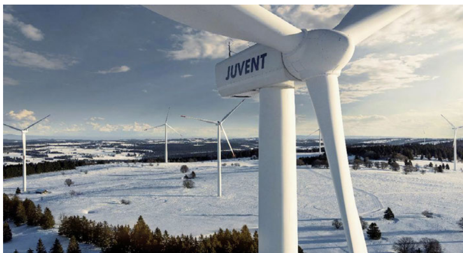
JUVENT hat alte Windkraftanlagen ersetzt.
