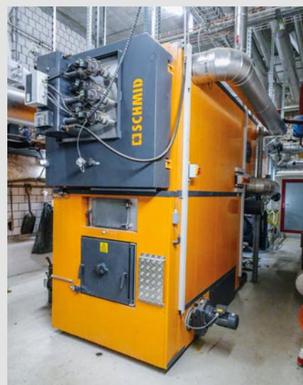
La chaudière à grille mobile d'une puissance de 550 kW peut être alimentée sans problème avec des copeaux de qualité inférieure.
