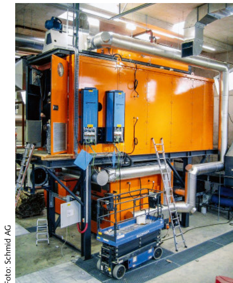
Die Wärme-Kraft-Kopplungsanlage mit Heissluftturbine in der Energiezentrale der Fernwärme Düdingen.
