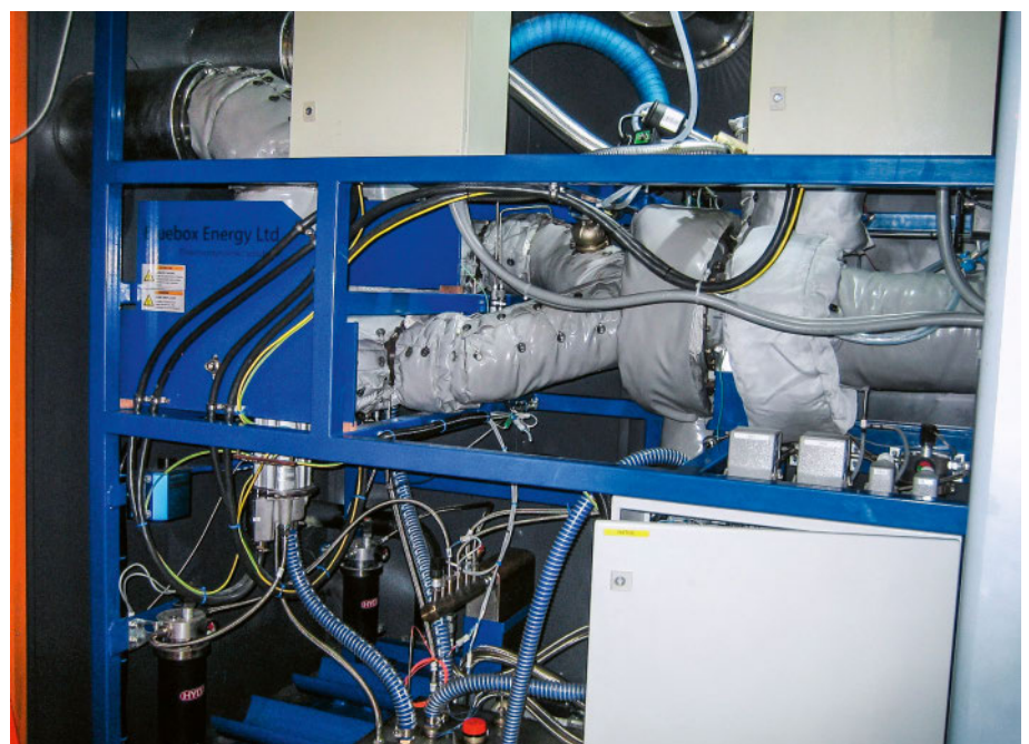
Detailansicht der WKK-Anlage in Düringen: die Turbogruppe mit isolierten Zuluft- und Abluftleitungen, Bypassventilen und Ölkühlungsleitungen.
