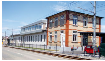
Le bâtiment de l'entreprise Swiss PV Testlab AG à Wängi (TG)
