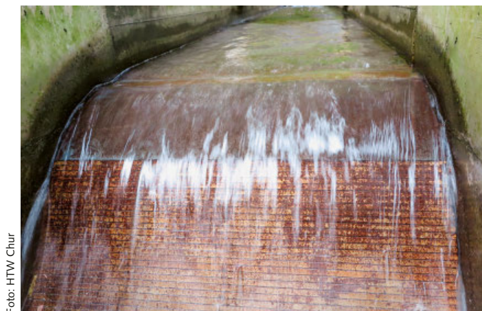
Nahaufnahme eines Coanda-Rechens: Die horizontalen Metallstäbe wirken wie Rasierklingen, die das Wasser schichtenweise abschern.
