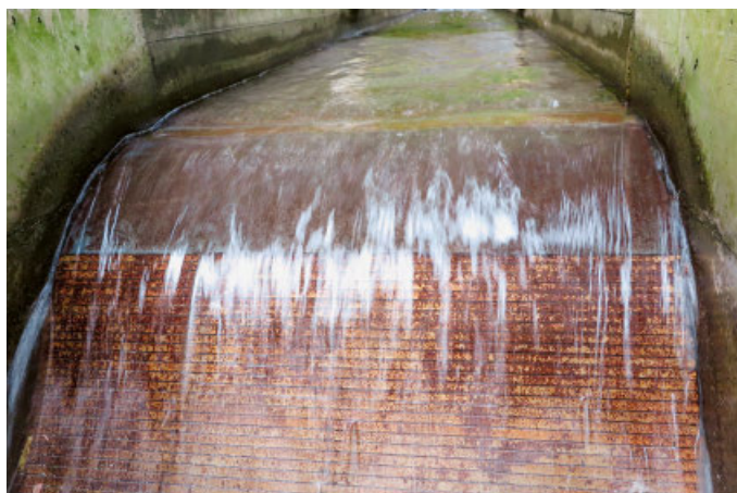
Gros plan d'une grille Coanda : Les barres métalliques horizontales agissent comme des lames de rasoir qui coupent l'eau par couches.
