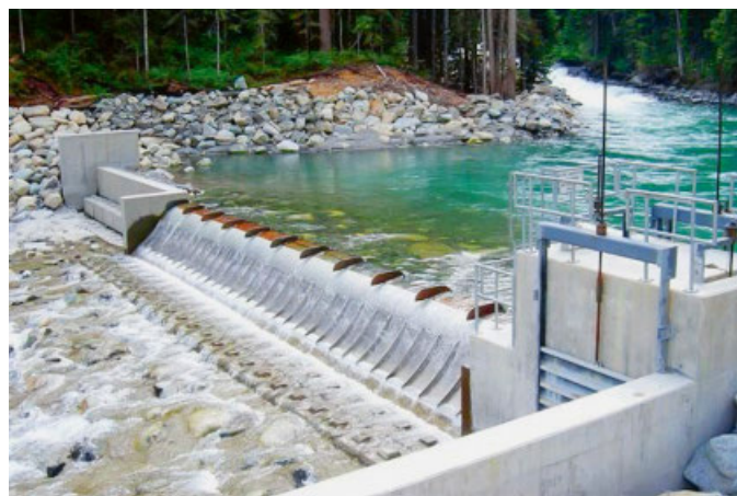
Grosse prise d'eau avec une grille Coanda au Canada (capacité spécifique de débit : 4000 l/s).
