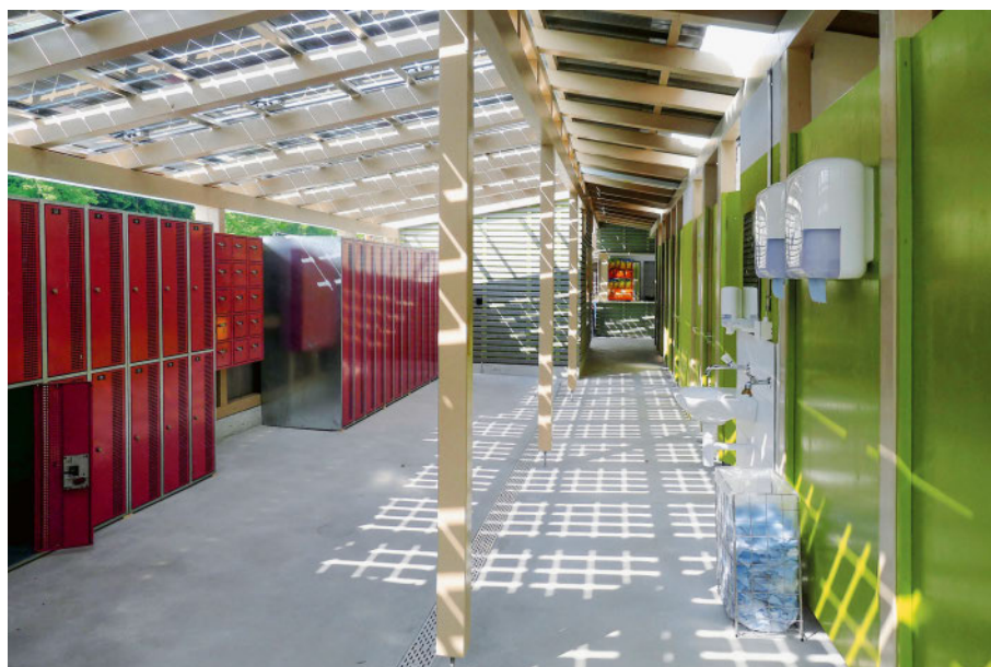
Les modules semi-transparents offrent des possibilités complètement nouvelles d'intégrer le photovoltaïque dans les bâtiments, comme ici dans le bâtiment des vestiaires de la piscine de Elgg.
