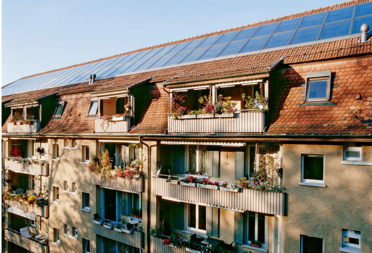
Le lotissement situé à l'Hammerstrasse 102 à Zurich montre que les capteurs solaires peuvent très bien être intégrés à la toiture.
