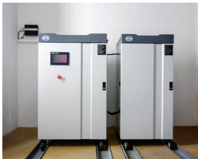
Die Azienda Elettrica Ticinese (AET) und die anderen beteiligten EVU haben jeweils einen stationären Batteriespeicher mit einer Speicherkapazität von 10 kWh eingesetzt.
