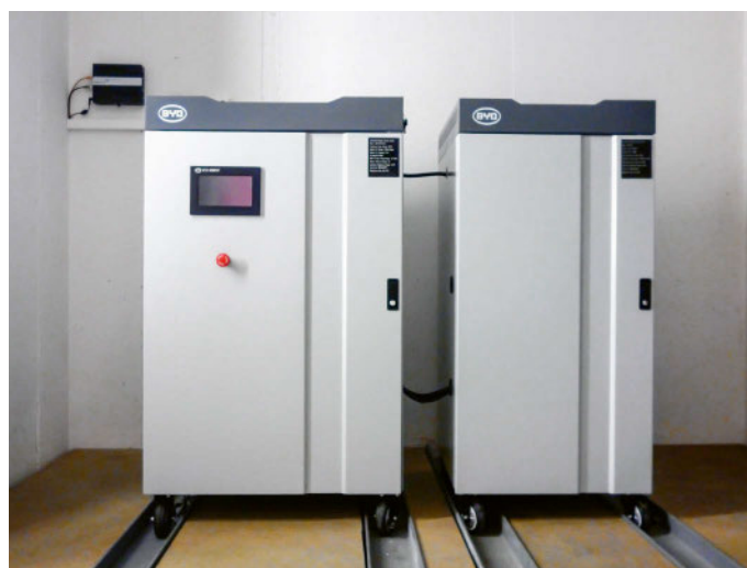
Azienda Elettrica Ticinese (AET) et les autres entreprises d'approvisionnement énergétique participant à l'étude ont installé des batteries stationnaires d'une capacité de 10 kWh.
