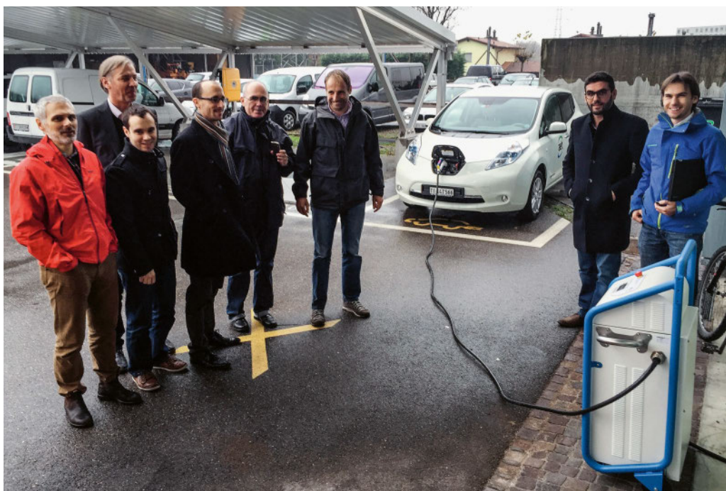
Une station de recharge bidirectionnelle pour véhicules électriques sur le site de test d'Aziende Industriali di Lugano (AIL).
