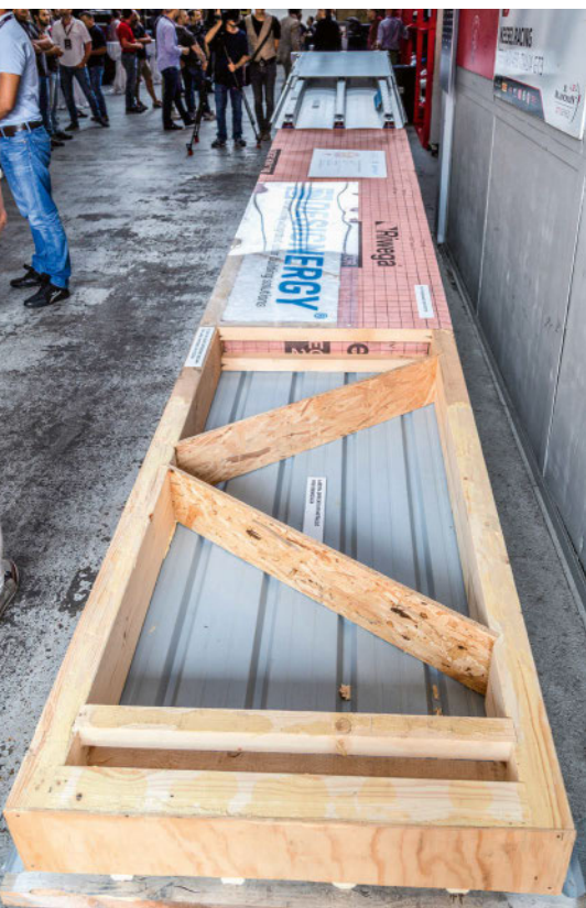
In der Vorfertigung werden sowohl die Dämmung als auch die PV-Module verbaut und dann die Elemente ganz aufs Dach gehoben.
