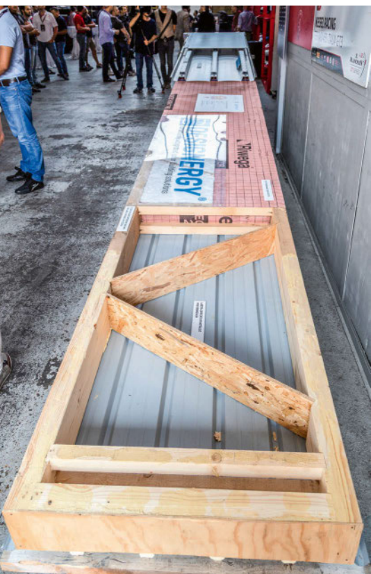
Lors de la préfabrication, tant l'isolation que les modules PV sont assemblés, puis les éléments sont posés sur le toit.
