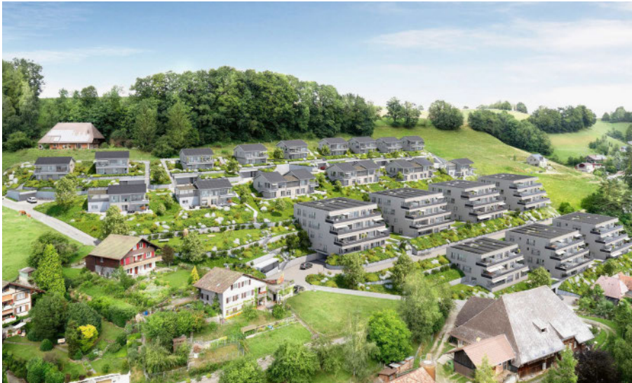
In Huttwil entsteht das erste Quartierstromnetz der Schweiz: Die 22 Gebäude werden mit der intelligenten Solarstromsteuerung von Smart Energy Link als eine einzige Eigenverbrauchsgemeinschaft betrieben.
