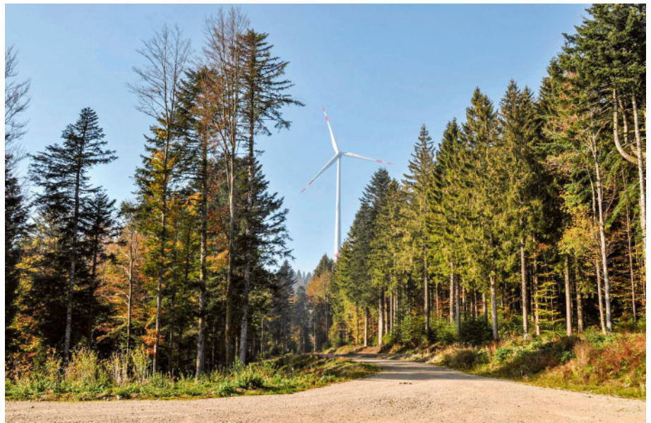
Die fünf Windkraftwerke der EWS haben je 3 MW Leistung und 149 m Nabenhöhe.
